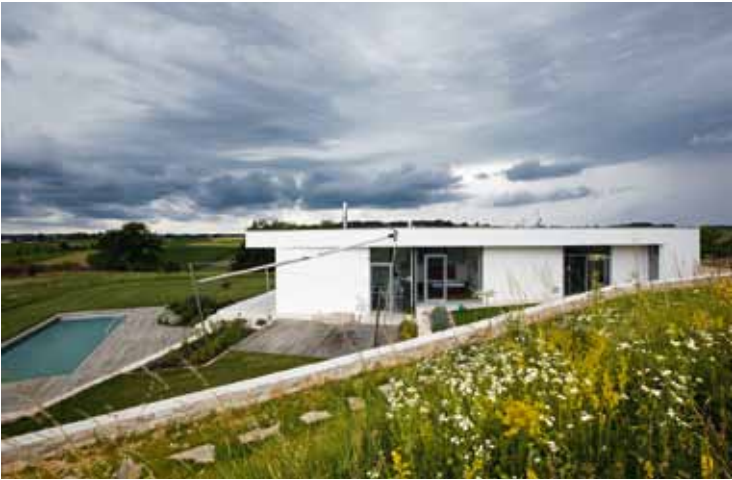
Unterhalb der Stützmauer gegen den Hang ergibt sich ein geschützter Sitzplatz.
