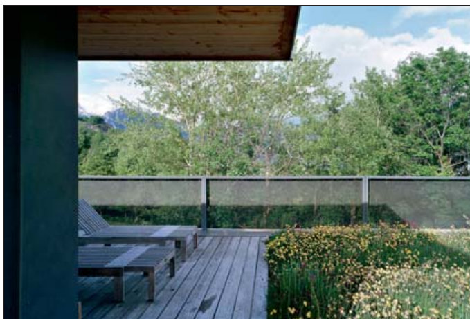
A hauteur de cimes, le toit-terrasse végétalisé.
