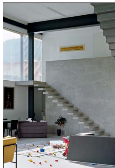
De simples marches en béton qui sortent du mur comme dans les murs de vigne valaisans.
