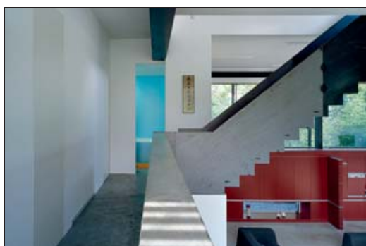
L'escalier suspendu qui mène au toit-terrasse porte les marques du travail de l'artisan.
